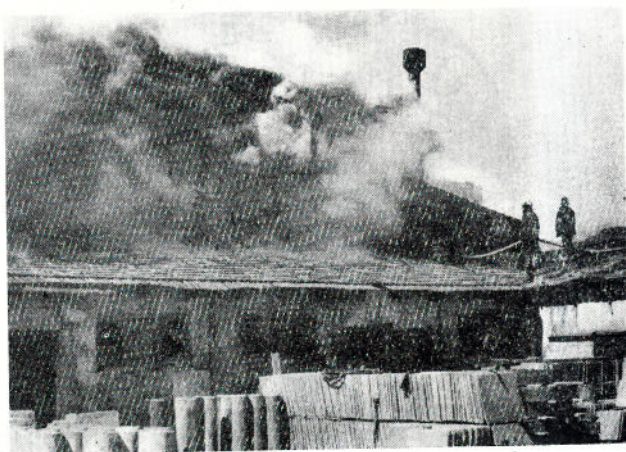
Otra fase del incendio. (Foto Guitart)
